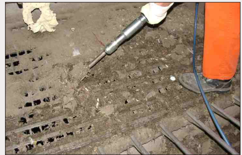
...Siebanlagen bei der Mülltrennung
